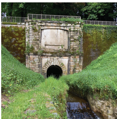
La voûte Vauban
